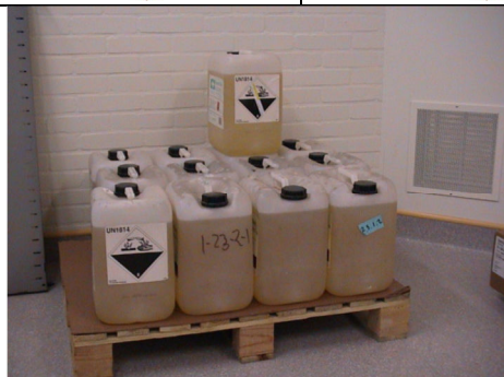
Opslag van gevaarlijke vloeistoffen (De vloer als lekbak)
