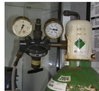
Gasfles met reduceerventiel
